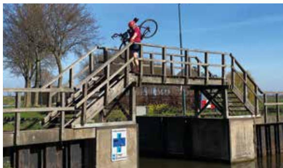
(te) steile voet-fietsbrug. Foto: Gerard Hof
